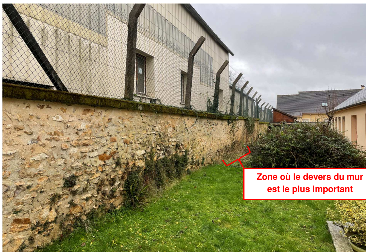
Photographies du mur de soutènement depuis la Pep28 – Source Ginger CEBTP
